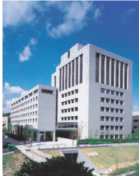
大和銀行千里センター(大阪・千里中央、1990年、現・りそな千里センター)
