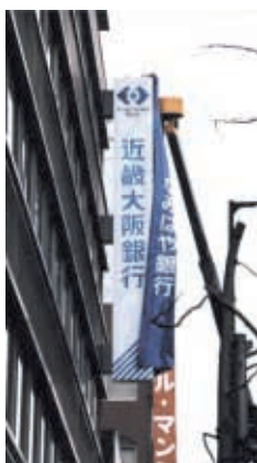
そで看板の取替え (平成13年2月12日 堺筋長堀支店)
